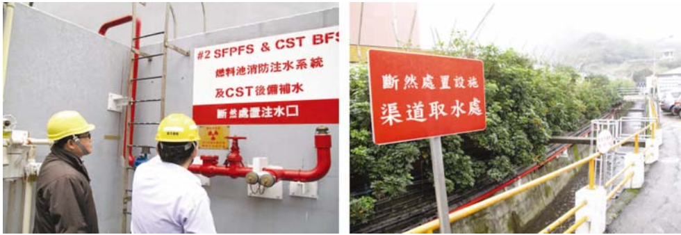
圖 I-6 (左) 斷然處置設備緊急補水至反應爐設備；(右) 斷然處置設備—渠道取水處。
